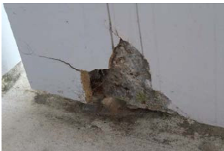
Abb. 3 Betonabplatzung bei Brüstungselement. An den Brüstungselemente der Laubengänge sind an mehreren Stellen Risse, Farbabblätterungen und Betonabplatzungen erkennbar.
