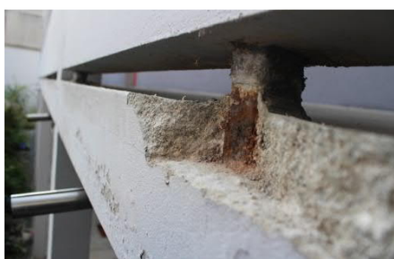
Abb. 12 Befestigung Betonbrüstung Laubengang. Die in den Beton eingegossenen Stahlwinkel sind mehrheitlich korrodiert.
