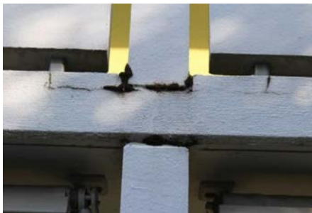
Abb. 4 Betonbauteilanschluss Stütze-Balkondecke. Bei Dilatationsfugen und Bauteilanschlüssen treten stellenweise Risse mit Moosbildung auf. Im Bereich der Befestigungen der Brüstungselemente weist der Beton diverse feine Risse.
