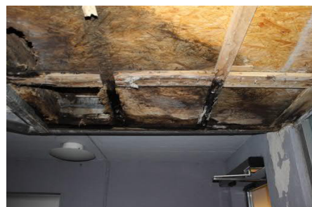
Abb. 17 Zustand Unterkonstruktion Laubengang. Die Unterkonstruktion (Lattung) und die OSB-Platten sind insbesondere im Übergangsbereich von Alt- zu Neubau stark beschädigt und teilweise komplett zerstört.
