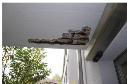
Abb. 11 Untersicht der Laubengangdecke Trakt C3. An mehreren Stellen sind erhebliche Betonabplatzungen und freiliegende korrodierten Bewehrungsseisen vorhanden.
