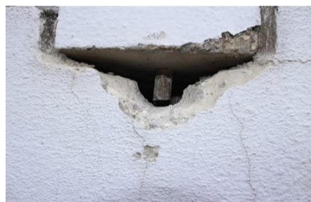
Abb. 10 Bauteilanschluss Stütze-Laubengangdecke. Die vorgefabrizierten Betonstützen sind mit einem Querkraftdorn an der Betondecke fixiert.
