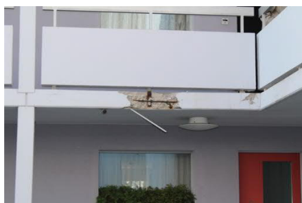
Abb. 13 Korrosion von Bewehrung und Stahlwinkel. An den Betonstirnen ist die Karbonatisierung tiefer als die Lage der Bewehrung und der Stahlwinkel eingedrungen.
