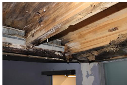
Abb. 18 Tragende Holzkonstruktion Laubengang. Es fehlt eine Abdichtung zwischen der Holzkonstruktion und dem Betonbauteil. Regenwasser infiltriert und führt zu Holzfäule im Bereich des Balkenaufagers. Die Tragsicherheit ist nicht mehr vorhanden!
